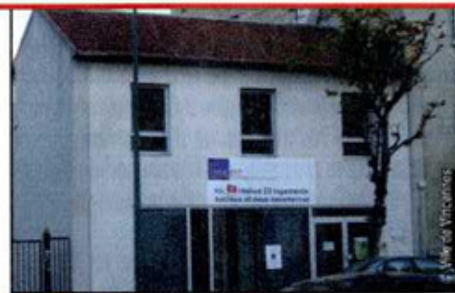
Rue Félix-Faure : création de 23 nouveaux logements sociaux et de deux commerces.
