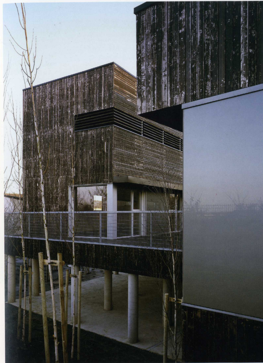
Portés sur pilotis les quatre logements sont accessibles du parking à rez-de-chaussée et par une passerelle sur leur flanc ouest
