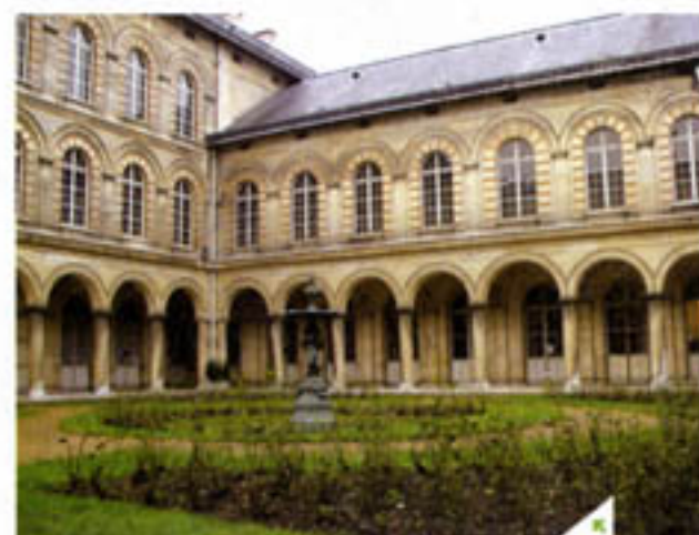
La maison de retraite Ferrari, établissement de 11 000 m 2 , se lance dans un chantier de rénovation de 4 années.
